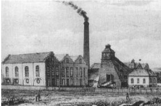
L'ancienne usine de forage du tunnel sous la Manche
