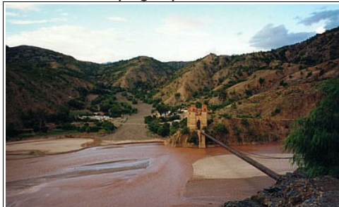
Pont suspendu sur le Rio Pilcomayo (sur la route de Sucre à Potosi)
