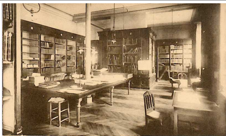
ECOLE CENTRALE DES ARTS ET MANUFACTURES — Bibliothèque
